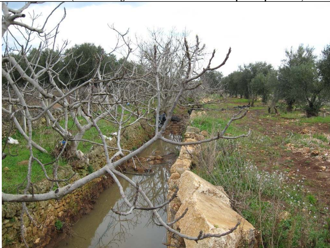
Foto 6 – Alveo del Canale Donnosanta a valle del tombino di attraversamento della S.S. 379.
