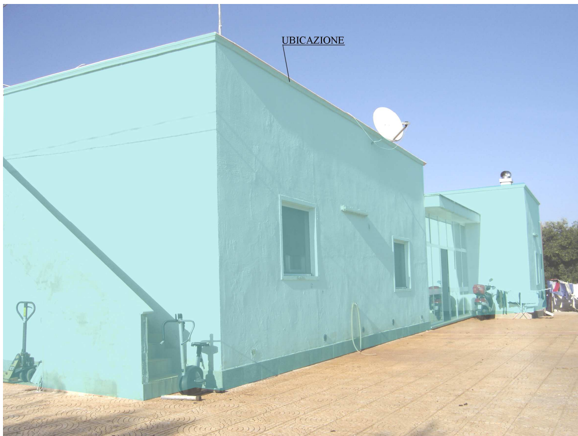
Particolare fotografico all'interno del lotto, in direzione sud.
