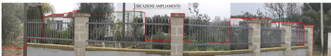
Vista panoramica con indicazione dell'altezza dell'edificato
