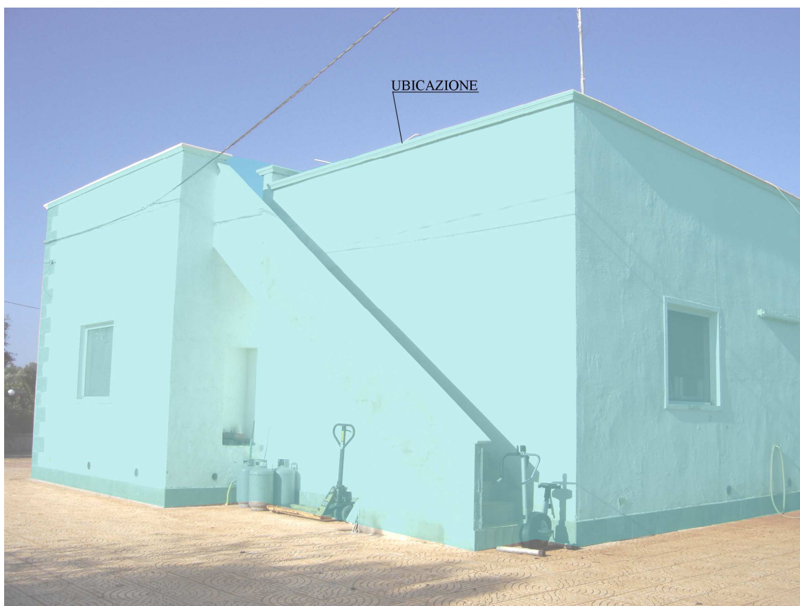
Particolare fotografico all'interno del lotto, in direzione nord-est.
