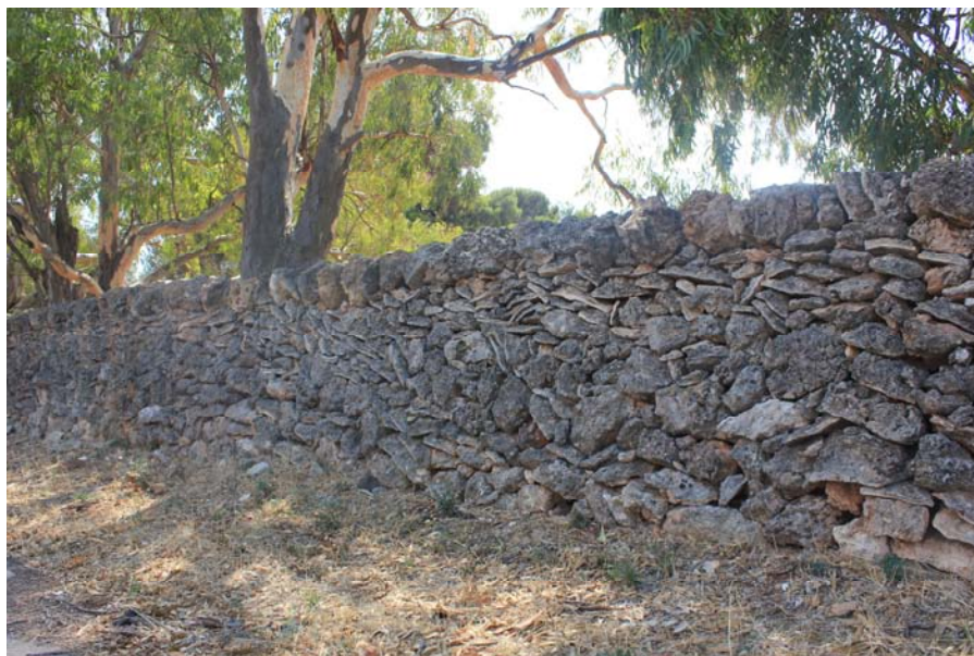
2. Tratto del tracciato della via AppioTraiana in territorio di Carovigno (Brindisi; foto I. Pecoraro, 2013)
